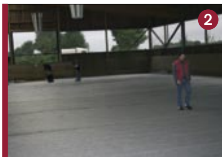
Lägger ut geotex duk
